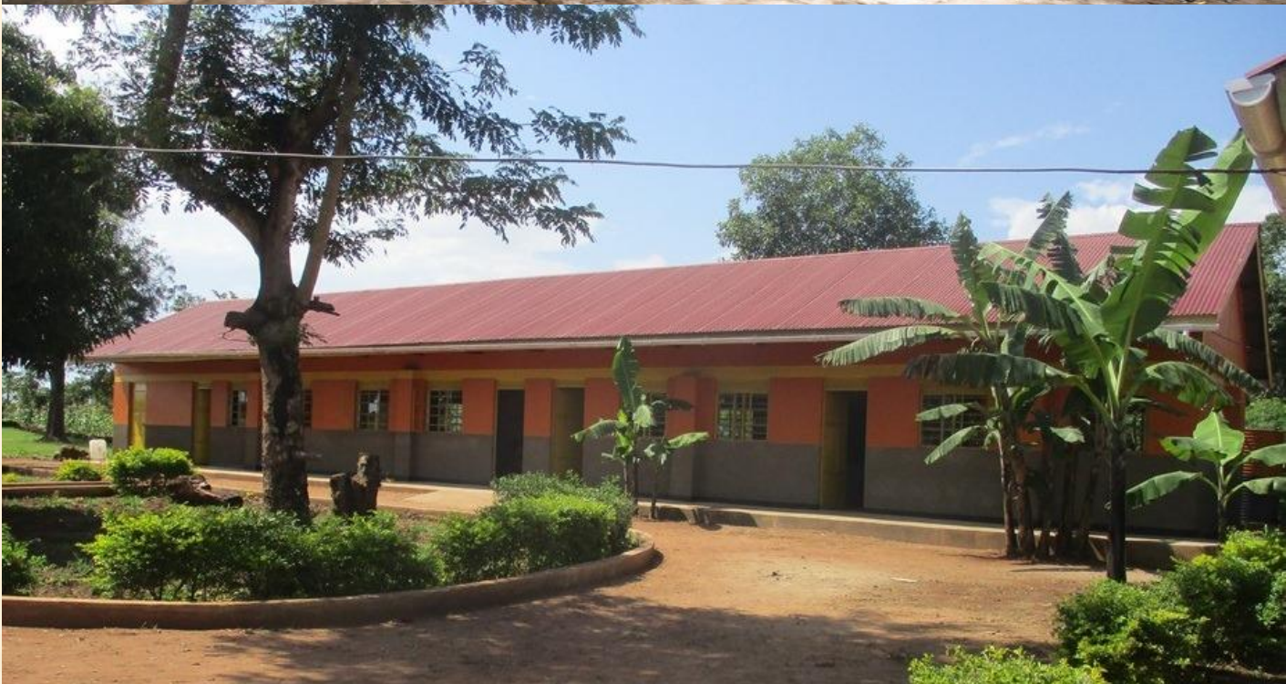
Antes y después del estado de la escuela de Namukubembe
